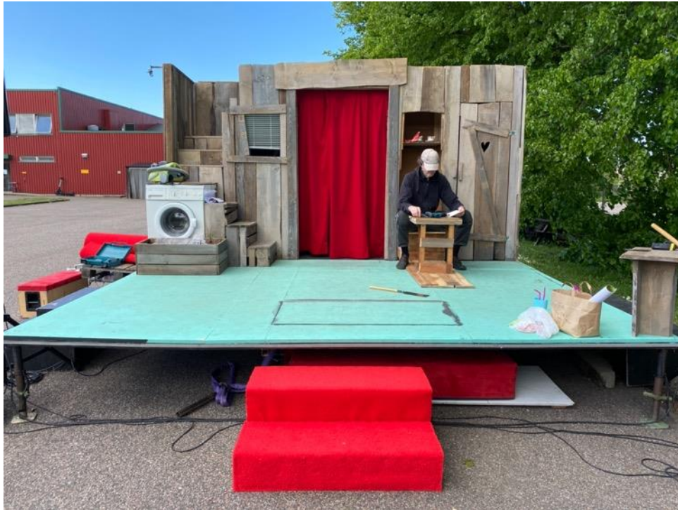
Foto på den nerfällda scenvagnen under pågående bygge.
